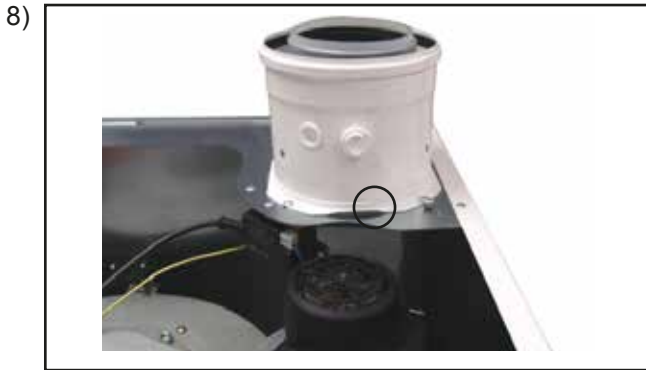
8) A felső burkolatfedél eltávolítása után lazítsa meg a levegő/füstgázcső reteszelő lemezcavarját.
